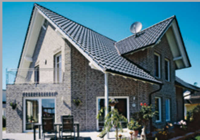
Wykończenie dachówką boczną prawą z deską szczytową*
