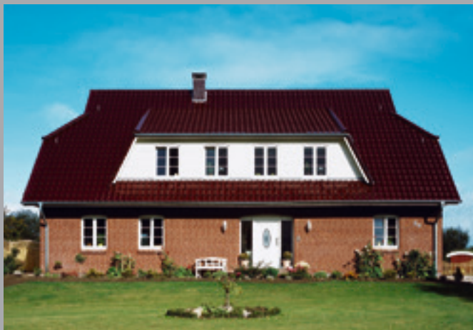
Wykończenie dachówką boczną lewą z deską szczytową*
